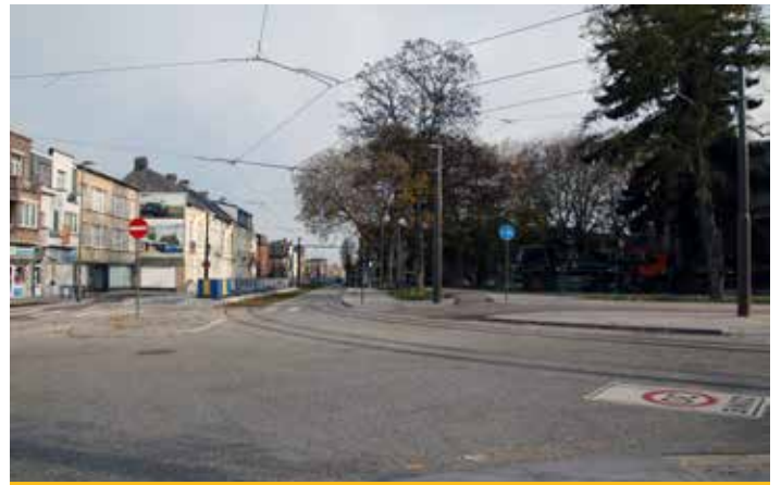
▲ Het eerste deel van de vernieuwde Kioskplaats werd al plechtig ingehuldigd.
