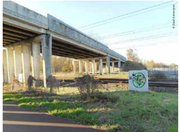
De oude Krugerbrug wordt vervangen door een volledig nieuwe fietsbrug.
